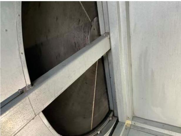
Der Wärmetauscher ist ein Rotationswärmetauscher, welche den Energiewechsel regenerativ durchführt. Dieser wurde auf Durchsicht überprüft und befindet sich in gutem Zustand und ist sauber.
