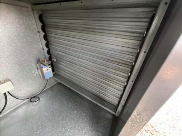
Die Stellenklappen wurden kontrolliert. Die Funktion ist beim ein und ausschalten gegeben, die Außen Luftklappe ist dicht.
