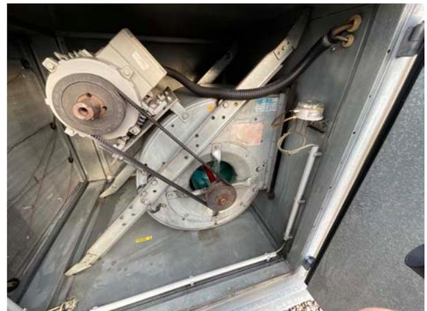
Das Lüftungsgerät wird von zwei Stück Ventilatoren mit Keilriemenantrieb betrieben. Die Riemenscheiben weisen keine Abnutzung auf. Die Keilriemen sind gut gespannt und die Lager sind noch in Ordnung.
