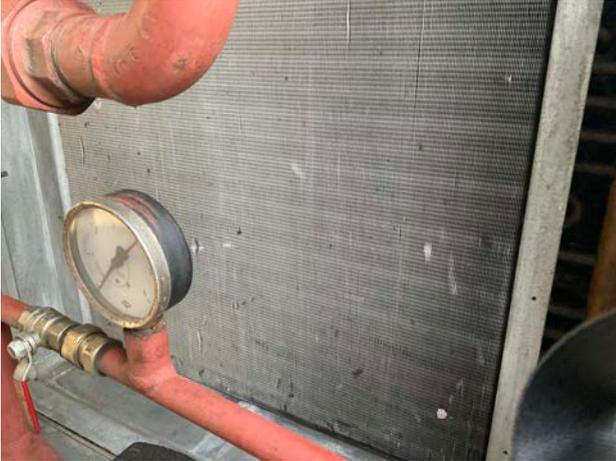
Das Register wurde auf Durchsicht überprüft. Die Aluminiumlegierung weist kleine Korrosion auf und ist in einem guten Zustand.
